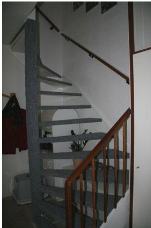
Afbeelding 26.3 Trap opnieuw bekleed en gereed.
